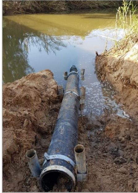
תרשים 3. מבט כללי על הצינור המגן בזמן ההתקנה
