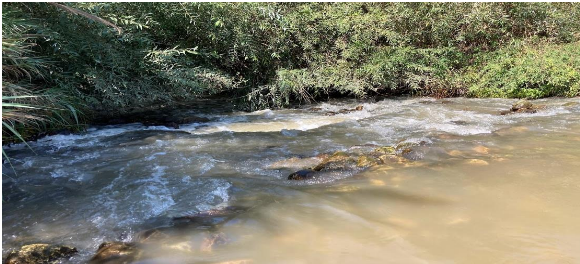
איור 6. מורד סכר תע"ש – קטע הסכר ותחילת הגלישה.
