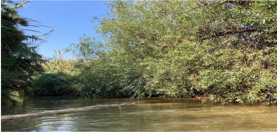
איור 8. מורד סכר תע"ש – קטע מורד התחנה.
