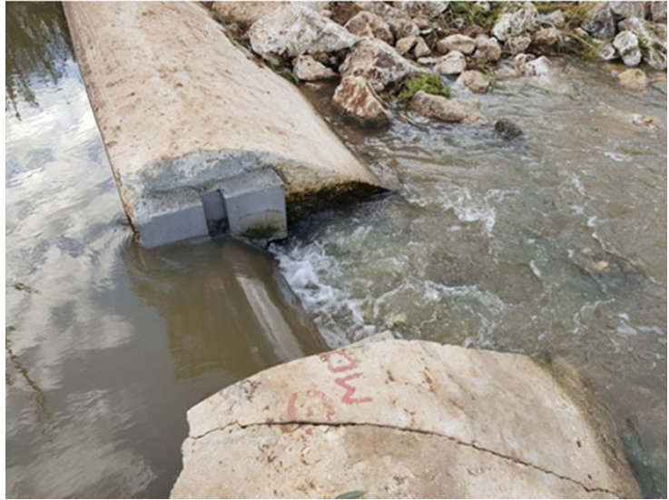
נזיר, פתח המים שנפרץ בקיר הטיית המים באתר עשר טחנות, מקור המים לסולם הדגים
