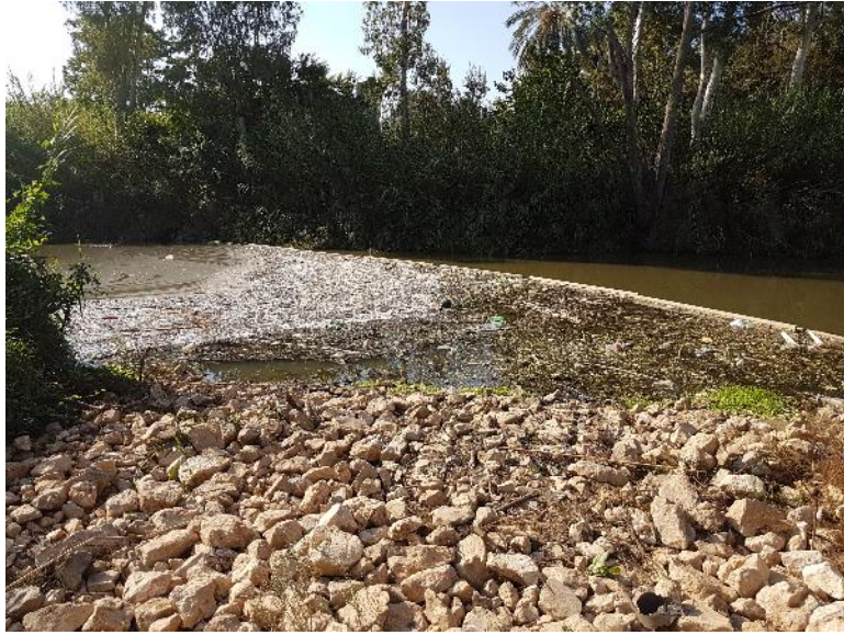
מחסום צף לרוחב האפיק לעצירה ואצירת פסולת לקראת הוצאה ופינוי מהאפיק
